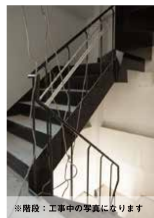
※2F：工事中の写真になります
